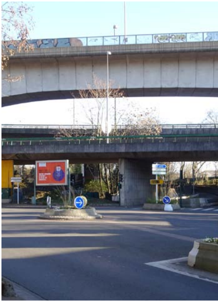
Saint-Maurice : Échangeur A4
