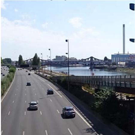
9 Charenton-le-Pont : Pont Nelson Mandela Amont
