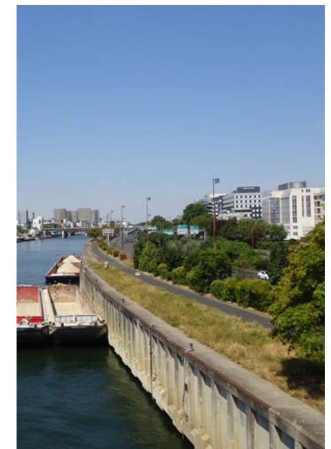
Charenton-le-Pont : Piste cyclable entre la Seine et l'autoroute A4
