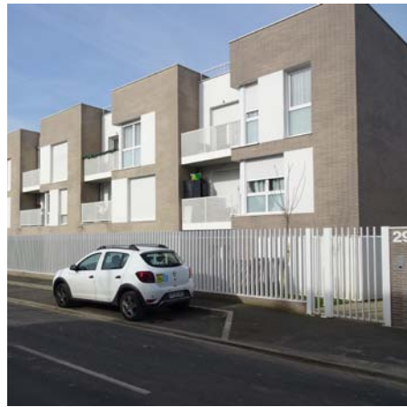
3 Chennevières-sur-Marne : Petits collectifs
