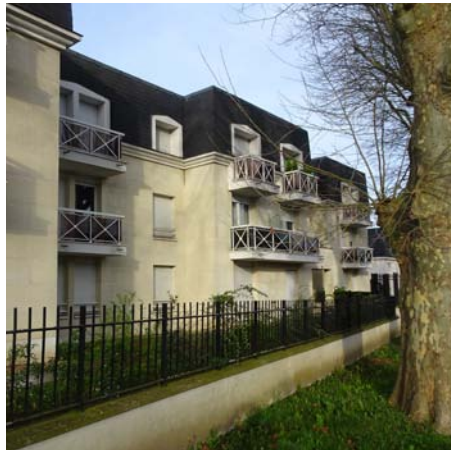
4 Villiers-sur-Marne : Résidence semi-ouverte
